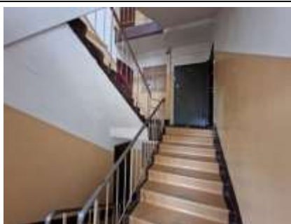
4.stāva kāpņu telpa
